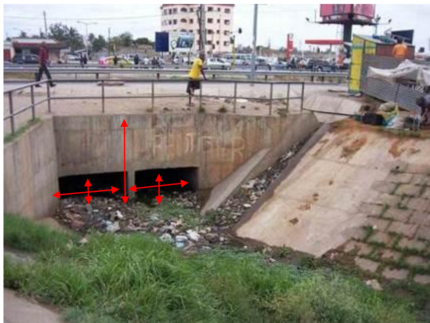
Figure 3-16: Culvert at crossing Av. Joaquim Chissano / Av. Acordos de Lusaka
